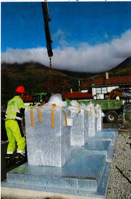
Figur 6 Nedsetting av nedgravde anlegg ved Berte Kanuttevegen i Ørsta..
